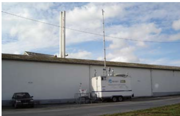
Station mobile ORAMIP à Rodez, Zone Industrielle Cataranne
